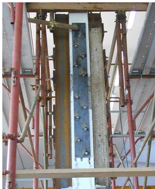
Riverticalizzazione con tiro di travi in ferro a contrasto con martinetto idraulico; successivo rinforzo con piastre e barre filettate inghisate con resina
