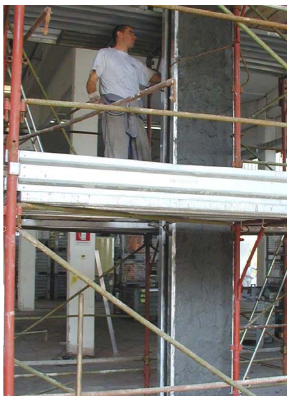
Rinforzo pilastro con integrazione di nuova armatura e ricostruzione con aumento dello spessore (cm. 6), con malta fibrata
