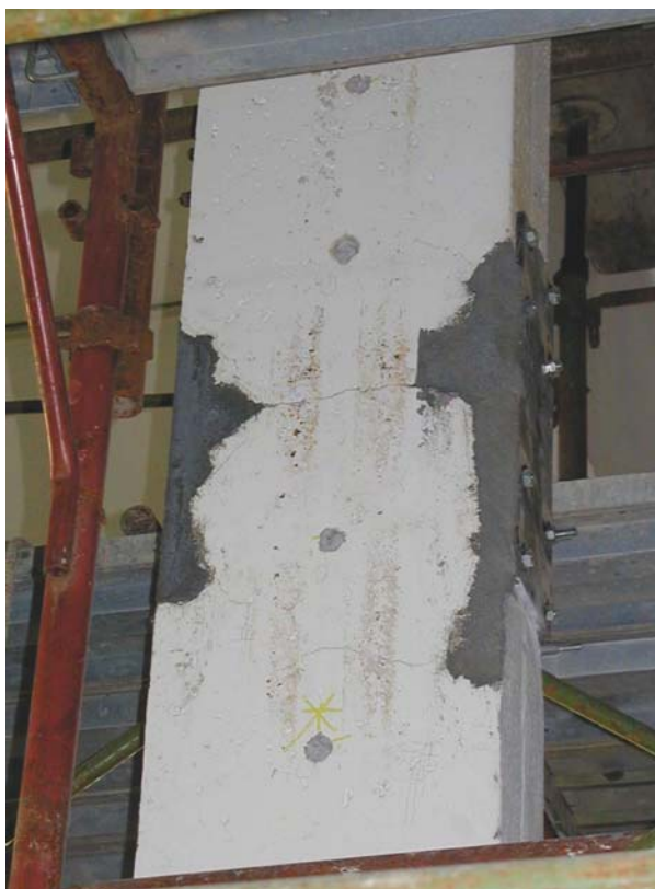
Rimozione e ricostruzione c.a. con cementi strutturali
